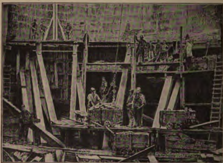
Fig. 139. — Puits sud. — Achèvement de la partie inférieure.
